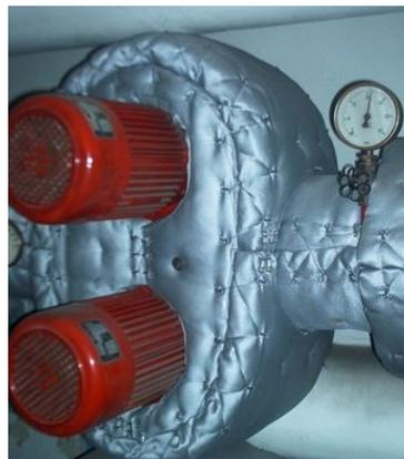
Die von TECHNO-Gewebe produzierten **Dämmmatratzen eignen sich hervorragend zur Wärmeisolierung**. Sie sind gefertigt aus zumeist unbrennbaren Materialien. Der Aufbau ähnelt einer Jacke oder einem Sofakissen. Die Hülle ist aus Glasgewebe und hält auch extremen Temperaturen stand. Die Füllung, beim Sofakissen wären das die Daunen, besteht aus hochtemperaturbeständiger Mineralwolle. Damit erreichen Sie eine ungeahnte
